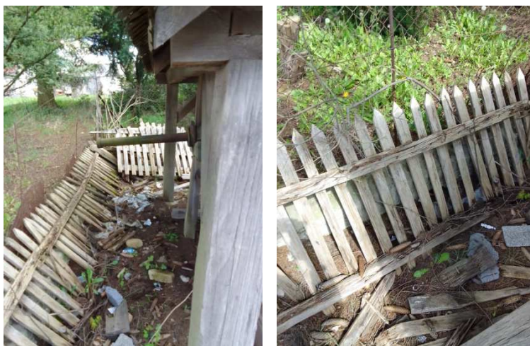
Fot. Obecne zniszczone ogrodzenie studni na działce nr ewid. 312 (nowe ogrodzenia na wzór obecnego).
