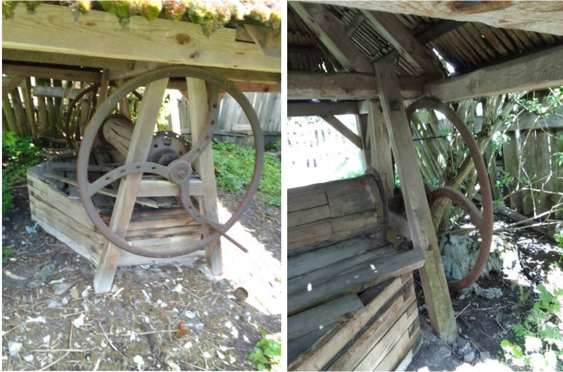
Fot. Studnia na działce nr ewid. 313.
