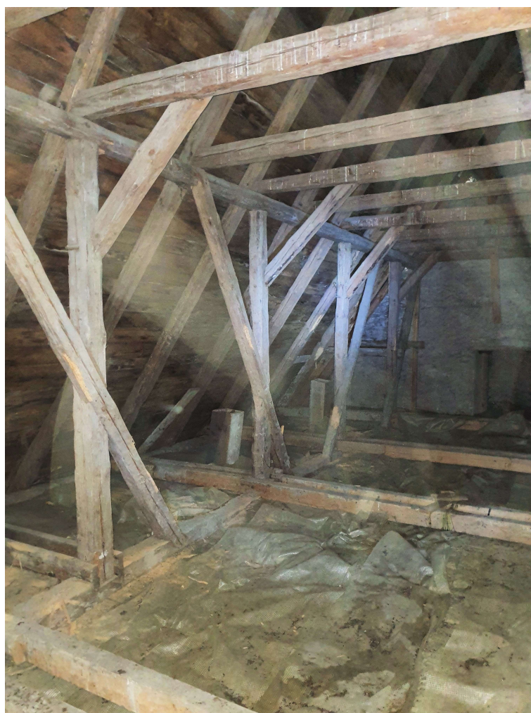
Ogólny widok więźby dachowej nad nawą główną
