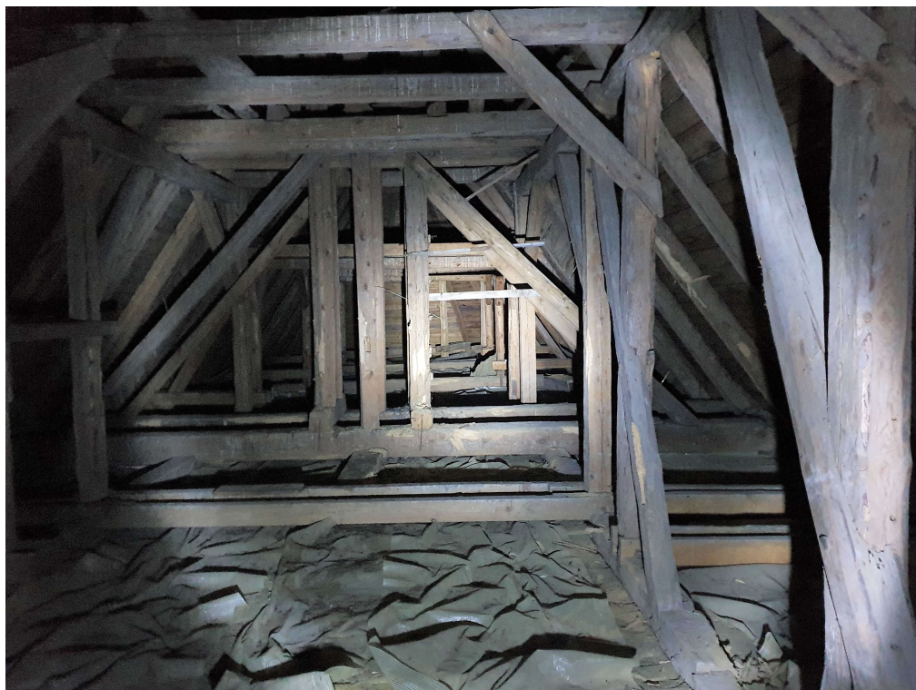
Ogólny widok więźby dachowej nad nawą główną i prezbiterium
