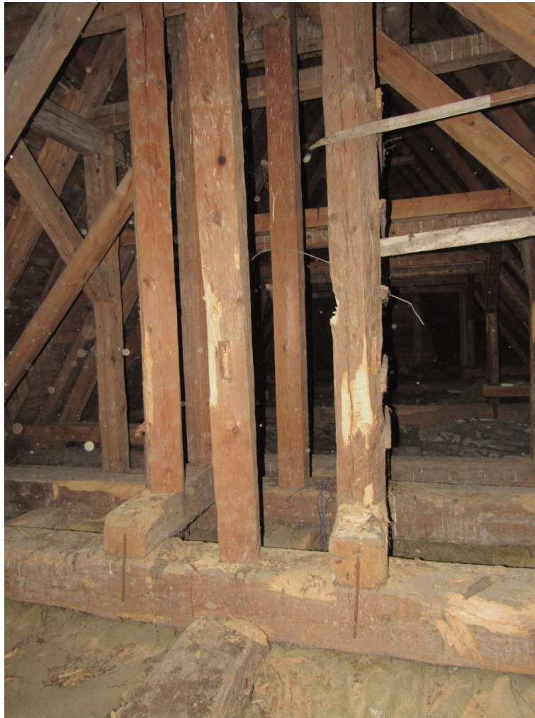
Stan techniczny elementów podstawy sygnaturki
