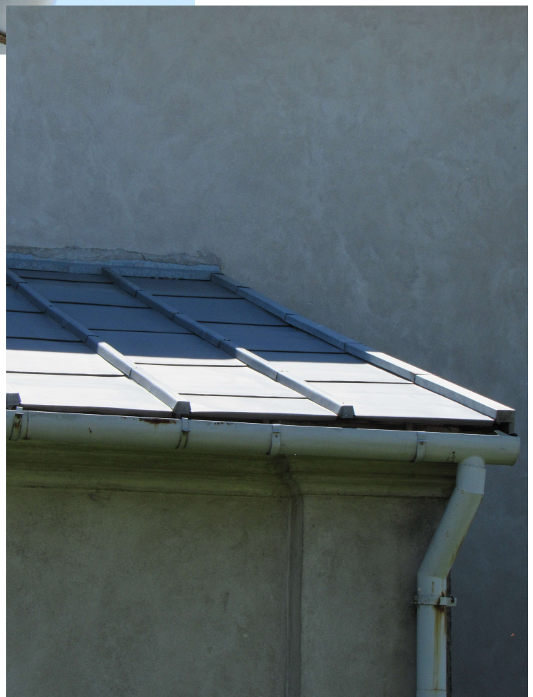
Stalowe rynny wiszące, przy dachu pulpitowym skarbczyka
