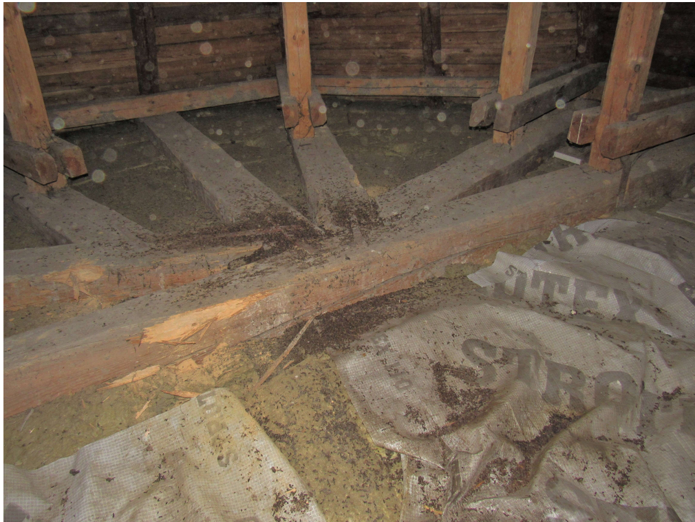
Belki więzaryowe/podwaliny w prezbiterium
