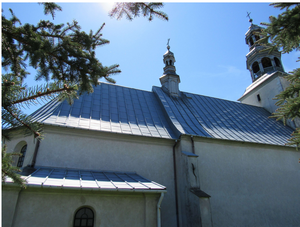
Widok kościoła od strony północnej. Pokrycie dachowe nawy i prezbiterium z blachy tytan-cynk montowanej z użyciem listew.
