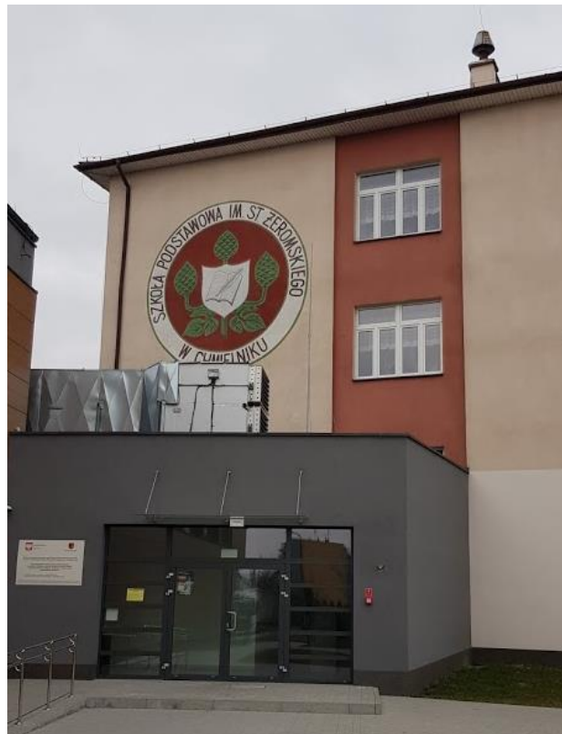
Fot. nr 3. Widok elewacji południowej
