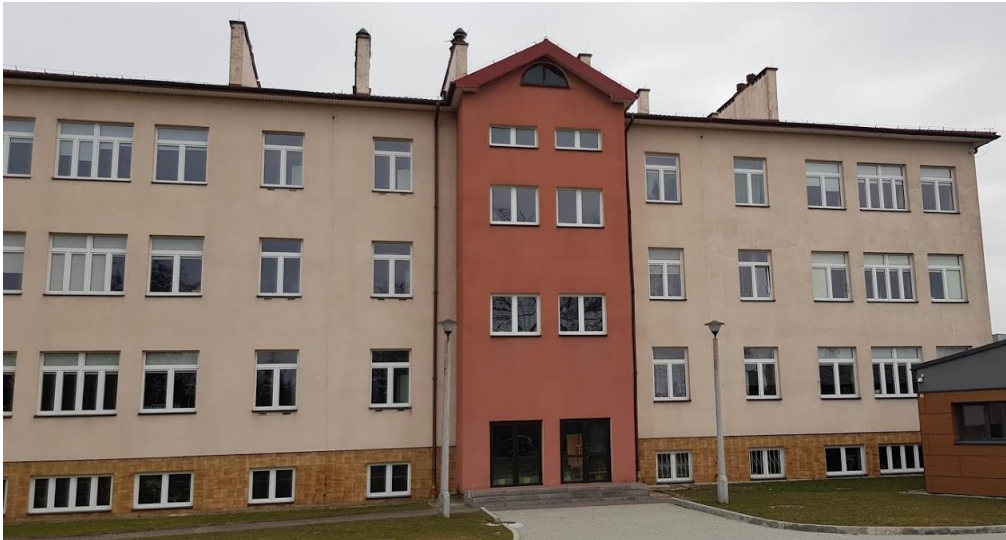
Fot. nr 1. Widok elewacji zachodniej
