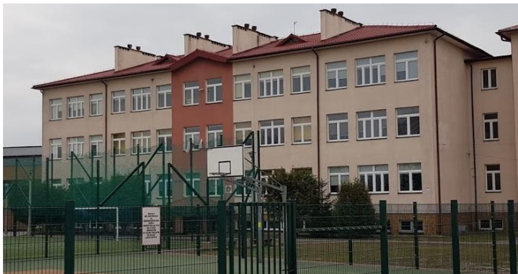
Fot. nr 2. Widok elewacji wschodniej i łącznika
