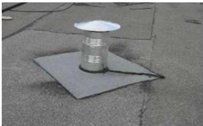
Zdj. Kominki wentylacyjne stropodachu.
