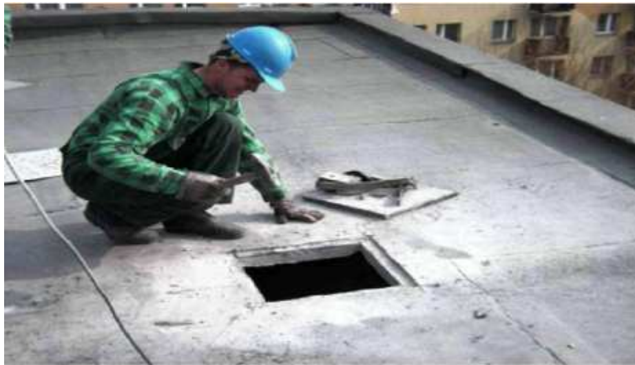
Zdj. Wykonanie otworu 50x50cm.
