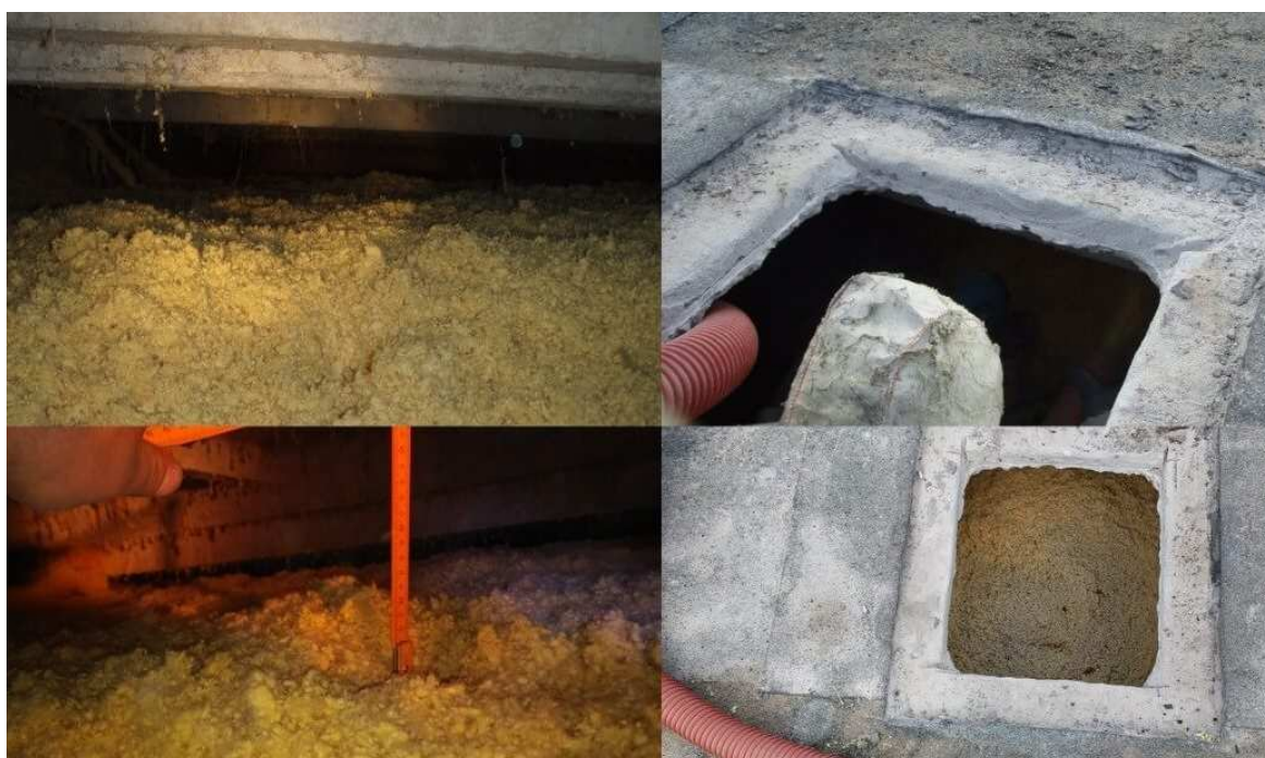
Zdj. Wdmuchiwanie granulatu.
