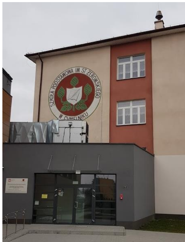
Fot. nr 3. Widok elewacji południowej
