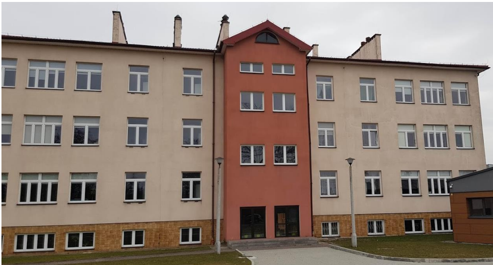
Fot. nr 1. Widok elewacji zachodniej
