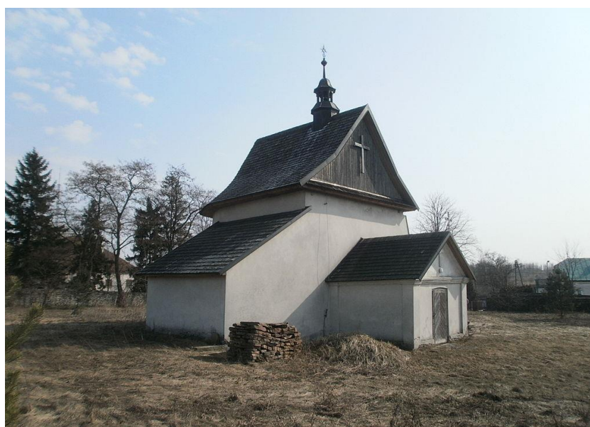
Zdjęcie 22 Kościół św. Trójcy w Chmielniku
