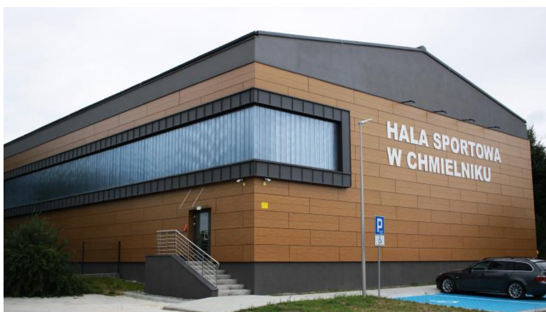
Zdjęcie 10 Hala sportowa w Chmielniku
