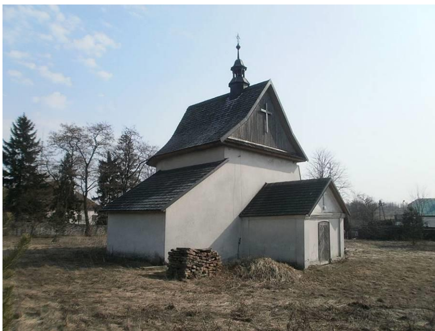
Zdjęcie 22 Kościół św. Trójcy w Chmielniku
