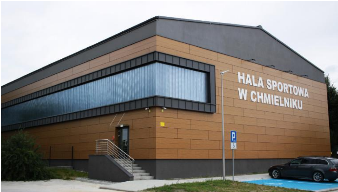
Zdjęcie 10 Hala sportowa w Chmielniku
